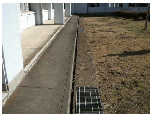
校舎基礎部分と側溝の隙間
