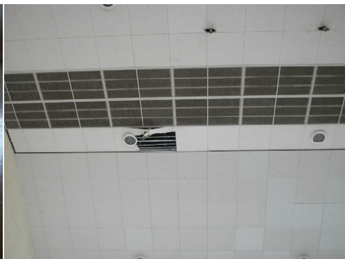
④体育館 天井のパネルが数枚が、破損し落下した。天井に隙間ができた。
