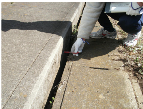
校舎基礎部分と側溝の隙間
