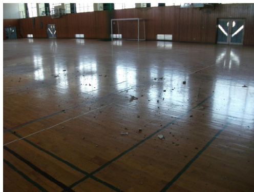
④体育館 天井のパネルが数枚が、破損し落下した。天井に隙間ができた。
