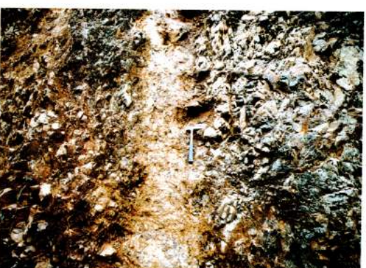
図Ⅱ-1-7 チャート層の断層
