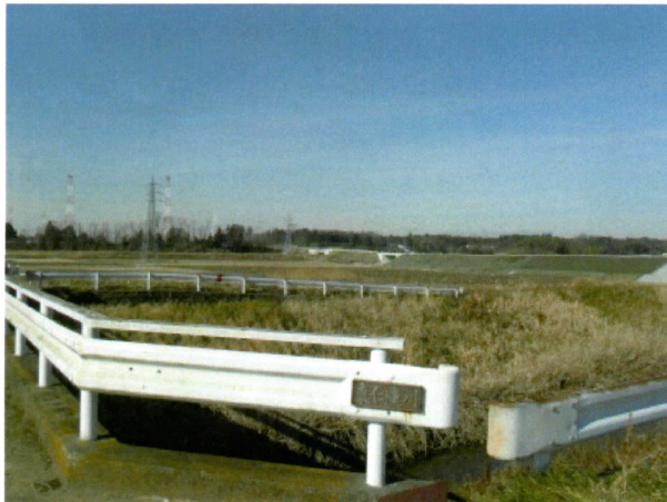
写真②東仁連川の橋から飯沼川・西仁連川を望む
