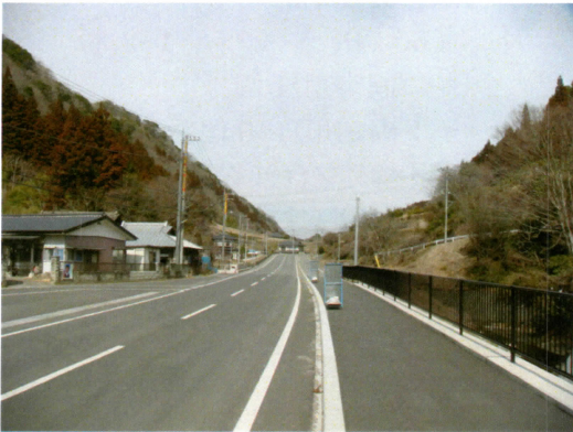
① 国道 4 6 1 号線坂下付近北方向
