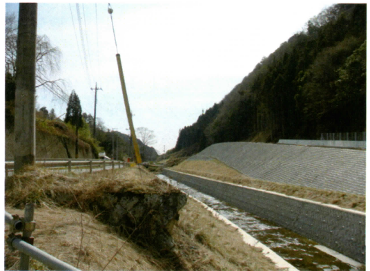
② 国道 4 6 1 号線坏付近南方向
